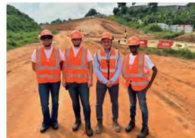
Hervé Leblanc, Directeur général adjoint international et grands comptes , en visite avec les équipes de SMABTP Côte d'Ivoire sur le chantier du futur métro d'Abidjan.
